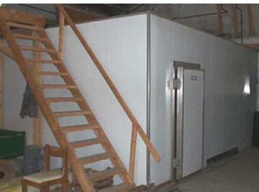
Figura 15: Cámara de paneles pre-formados (Gentileza Cooperativa de Fruticultores de El Hoyo. El Hoyo - Chubut) y vista de un detalle de los paneles que la constituyen (Adaptado de la Empresa Friolatina. Mendoza, Argentina)
